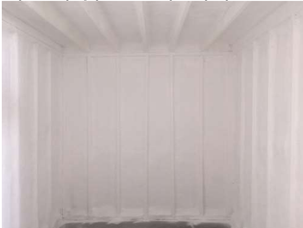
Figure 2. Exemple où le produit (de couleur blanche) sert de barrière thermique appliquée sur l'isolant en mousse de polyuréthane pulvérisée de densité moyenne posé dans les cavités (et sur les poteaux et les solives exposées) (1) dans l'ossature en bois des murs et du plafond d'un sous-sol.
