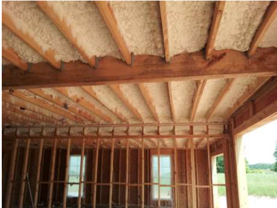
Figure 1. Exemple où le produit peut servir de barrière thermique appliquée sur l'isolant en mousse de polyuréthane pulvérisée de densité moyenne posé dans les cavités du plafond (et les solives) (1) d'un garage à ossature de bois. Dans la photo, la mousse isolante n'a pas encore été protégée par la barrière thermique offerte par le produit DC 315.
